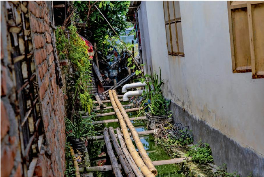
Abwassersysteme sind in den Slums dringend nötig. Die weissen Röhren (Bildmitte) leiten Urin und Kot von Toiletten direkt in den Bach.
